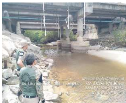
Imagem– Fiscalização realizando vistoria
