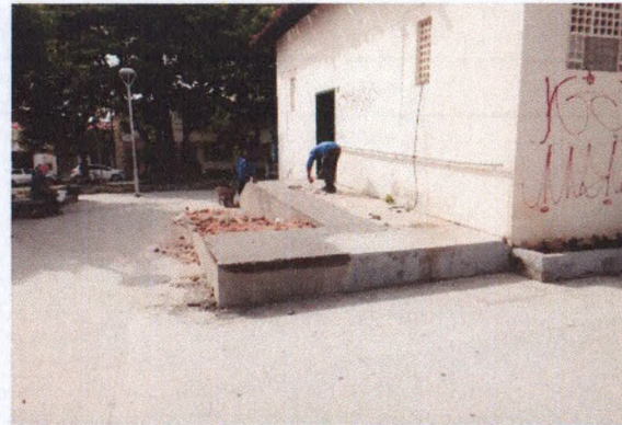
Figura 20 – Acompanhamento da obra da Praça da Alegria, referente à acessibilidade.
