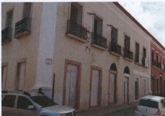
Figura 07 – Restauração/requalificação dos imóveis situados à Rua da Palma, nº 195-205.
