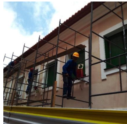
Foto 04 – Pintura de esquadrias de madeira
