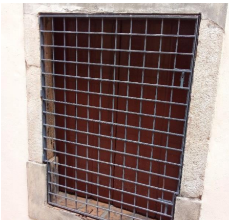
Foto 05 – Pintura de gradil
