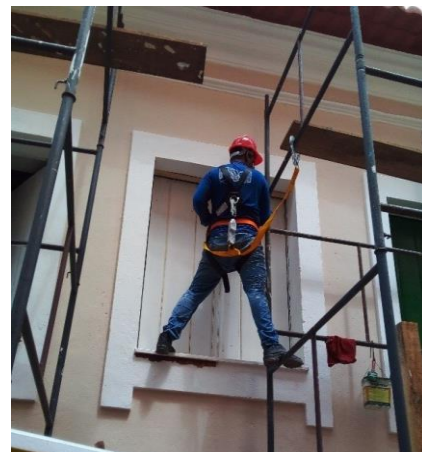
Foto 06 - Limpeza de moldura de pedra
