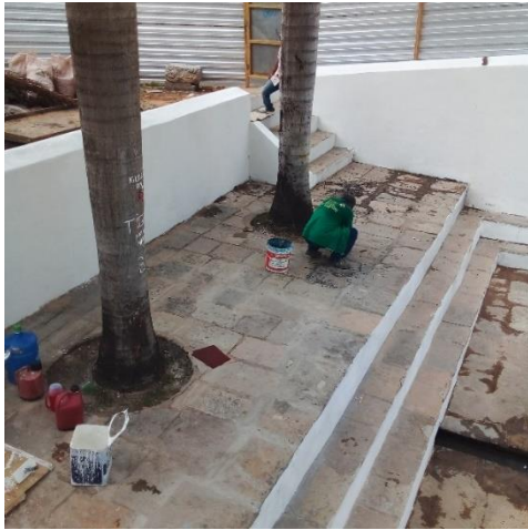
Foto 01 – Fechamento de aberturas no piso
