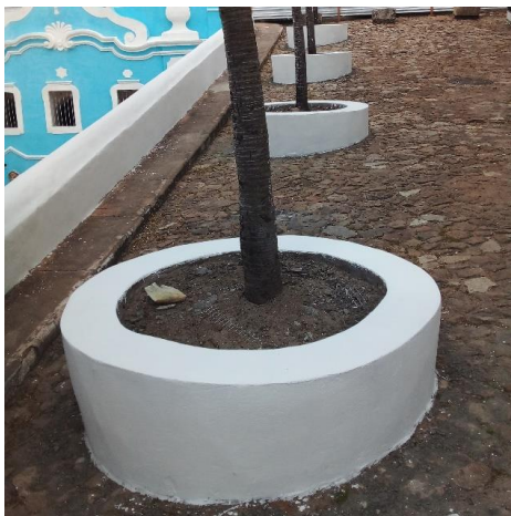
Foto 03 – Manutenção de canteiro
