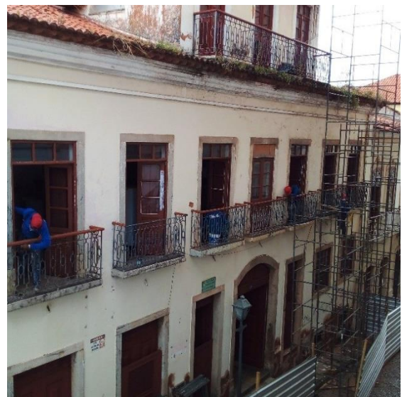
Foto 10 – Pintura dos corrimãos de madeira
