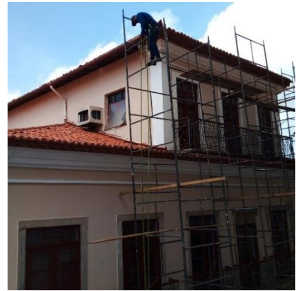
Foto 08 – Alinhamento de telhas
