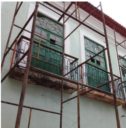
Foto 03 - Revisão de esquadrias de madeira
