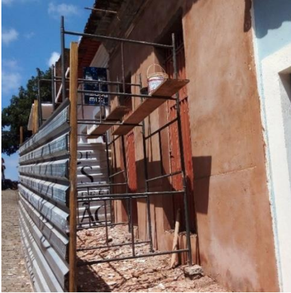
Foto 01 - Recomposição de reboco
