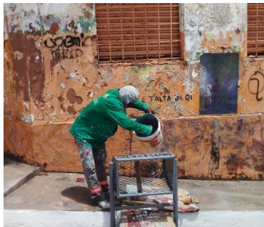
Foto 06 – Manutenção de lixeira
