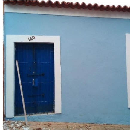
Foto 02 - Pintura de alvenaria
