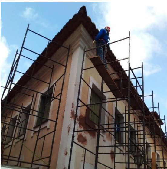
Foto 09 – Substituição de telhas
