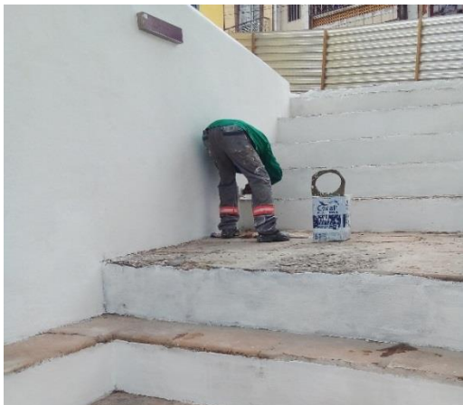
Foto 05 – Proteção de piso com resina
